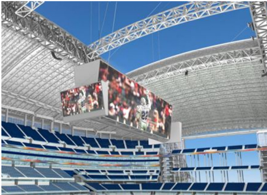
Hình 2: bảng hiển thị LED ở Dallas Cowboys New Stadium. 21,6 m x 48 m với 10,5 triệu LEDs [Mitsubishi Electric Diamond Vision] [2]
